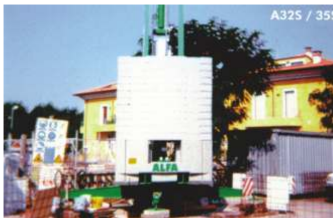
БЛОКИ ДОПОЛНИТЕЛЬНОГО БАЛЛАСТА МАССОЙ ПО 1250 кг.
